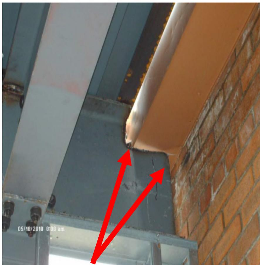
Besoin de sceller l'espace entre le platelage et une poutre pour éviter la pénétration d'air.
