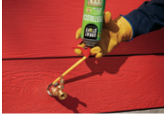
Penetración del grifo del agua
