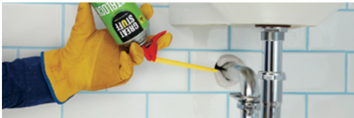
Penetración de plomerías
