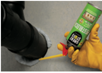
Penetración de tubos de PVC
